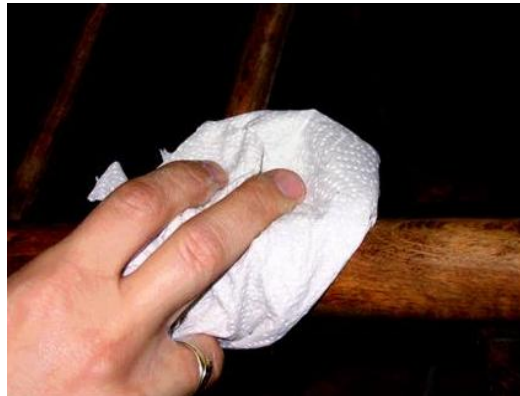
Slika 17: Nevtraliziranje površine z belim špiritom
