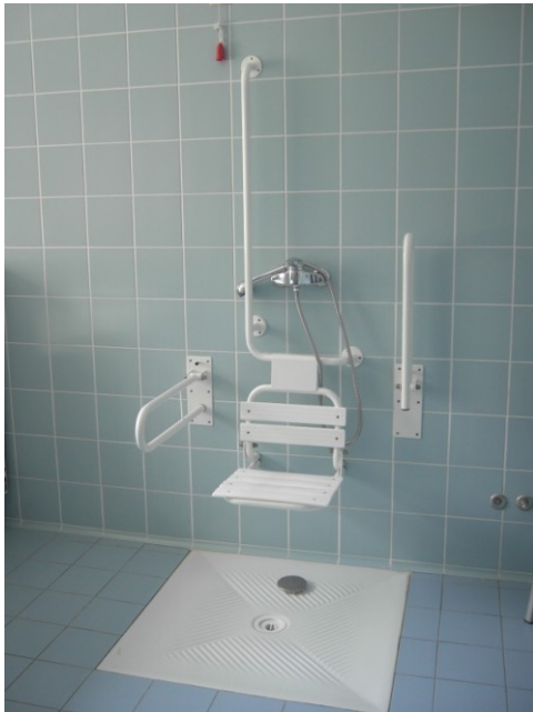
Slika 12: Oprema prhe z držali in preklopnim sedežem
