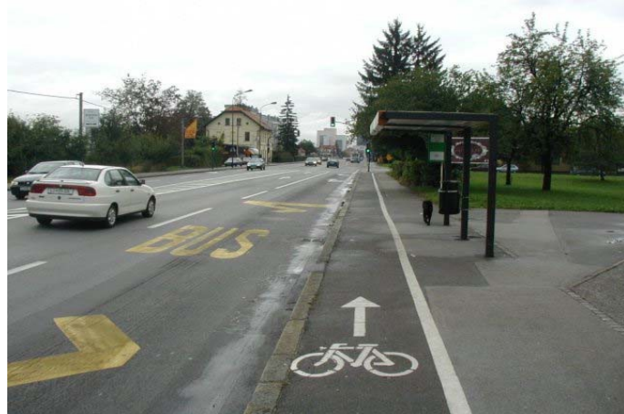
Slika 73: Avtobusno postajališče izven vozišča (Sternad, 2008)
